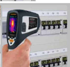
Análise de fusíveis sobrecarregados
